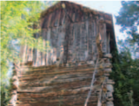
Fotoğraf 36: Karaş Mahallesi - Parsel:7
