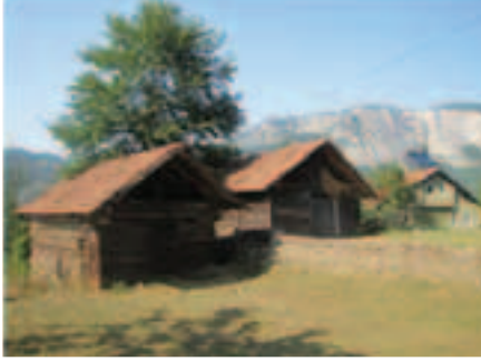
Fotoğraf 32: Karaş Mahallesi - Parsel: 7
