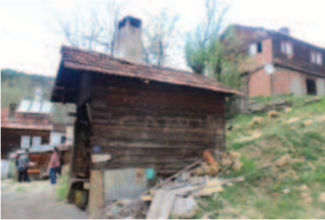
Fotoğraf 37: Karaş Mahallesi - Parsel: 7
