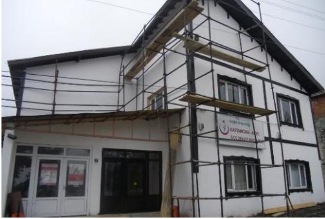
Küre İlçe Devlet Hastanesi yapım aşaması, 2013
